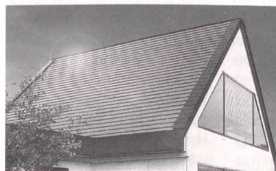
Das System vereint Dacheindeckung und Energiegewinnung (oben).
