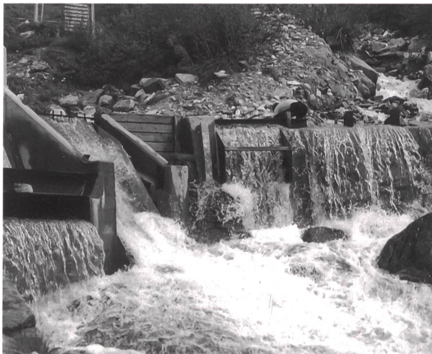
Bild 5 Pilotinstallation bei Hochwasser.
