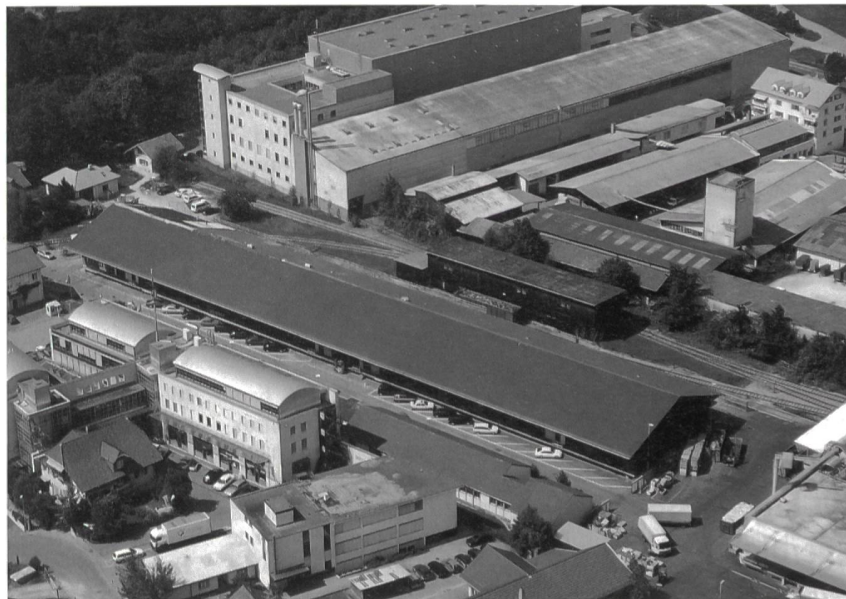
Weltgrösstes Solarziegdach (Bildmitte: 2000 m 2 Sunslates) des eidgenössischen Getreidemagazins in Bern (Nennleistung 200 kW, Bild EWB).
