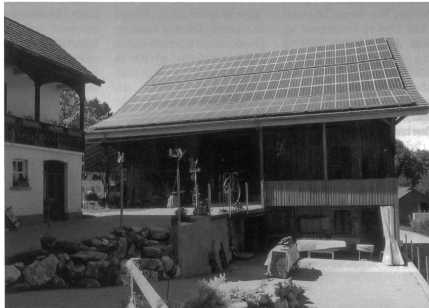
24-kW-Solarzellenanlage auf einem Scheundach in Maur ZH (Bild EKZ).
