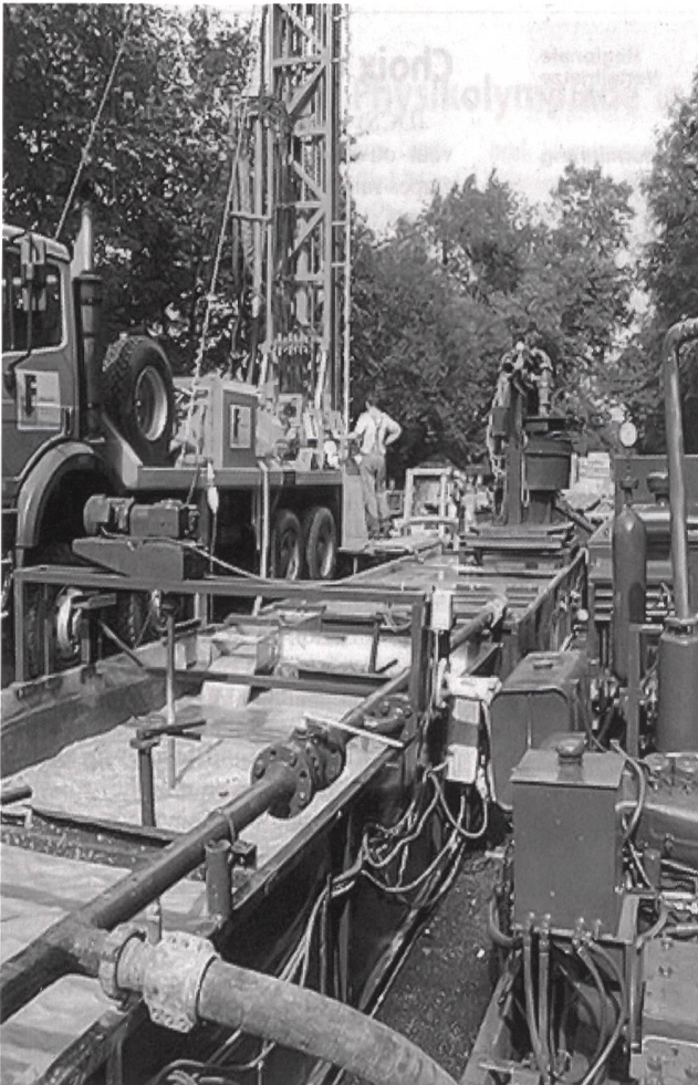
Aktuelle Aufnahme der Probebohrung Otterbach. Erweist sich der Standort als geeignet, könnte das geplante Erdwärmekraftwerk ab 2006 Strom und Wärme für etwa 5000 Haushalte produzieren.
