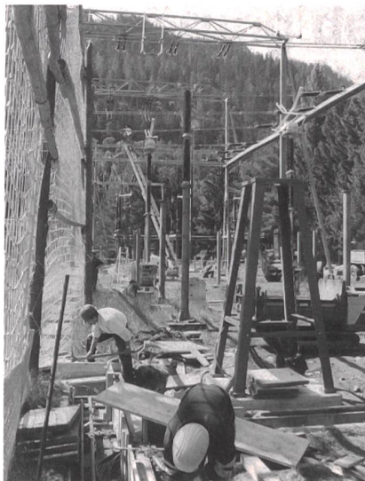
Bild 4 Baustelle der 220-kV-Freiluft-Schaltanlage.
