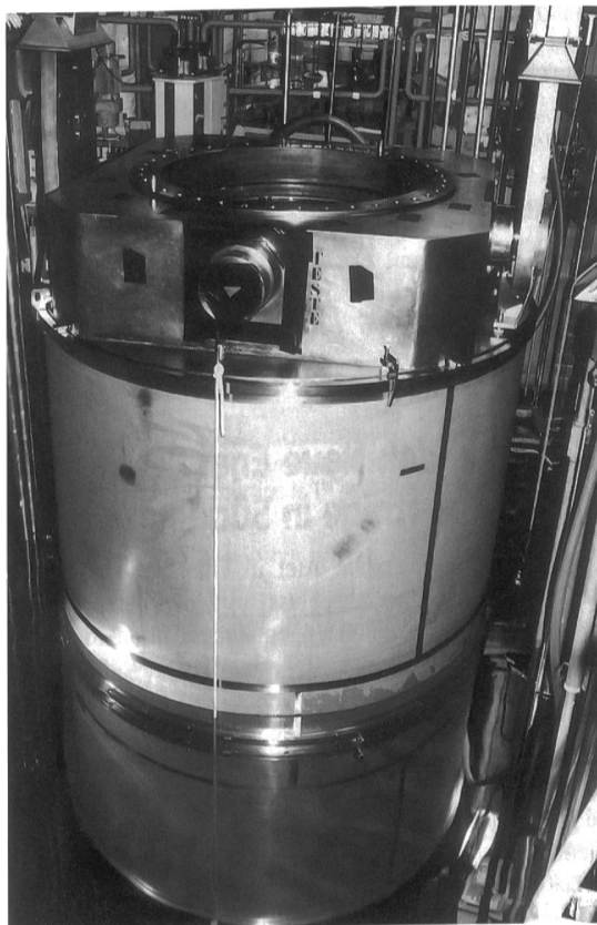
Der Transportbehälter wird in das Beladebecken abgesenkt.
