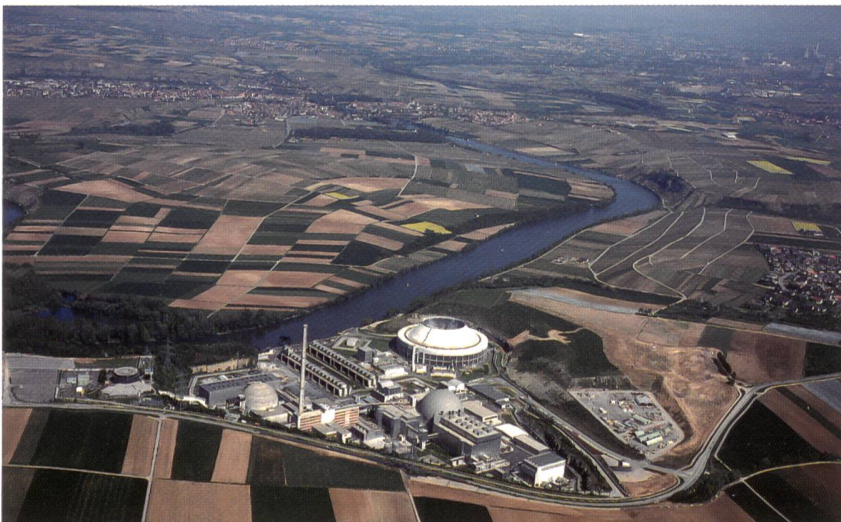
Kernkraftwerke besorgen in Deutschland 29% der Stromproduktion (im Bild Kernkraftwerk Neckarwestheim; Photo EnBW).
