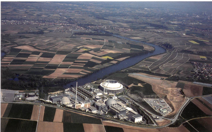
Kernkraftwerke besorgen in Deutschland 29% der Stromproduktion (im Bild Kernkraftwerk Neckarwestheim; Photo EnBW).
