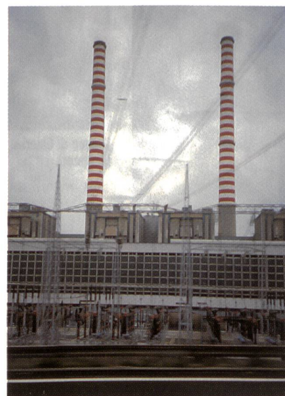
Italien: nahezu 80% der Produktion durch konventionell-thermische Kraftwerke (hier ein Ölkraftwerk bei Savona).
