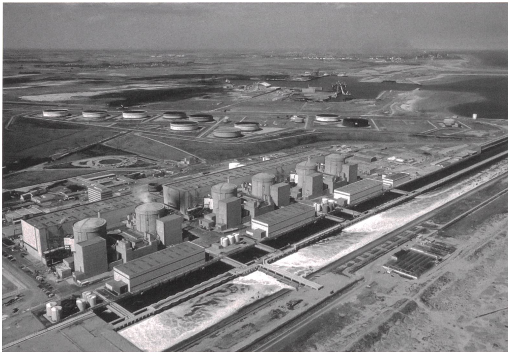
Kernkraftwerk Gravelines (Frankreich; Photo EDF).
