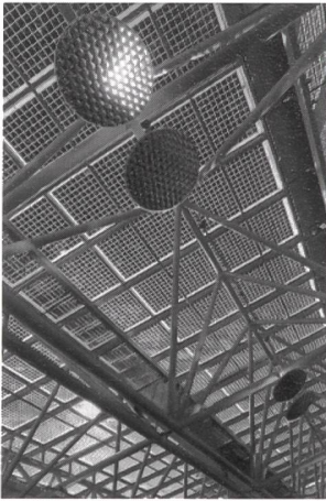
Solarstromanlage auf dem Glasdach am Migros-Hauptsitz in Zürich.
