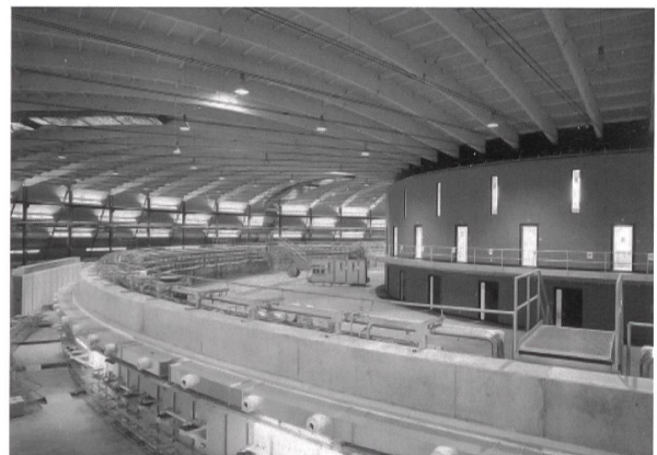
Das architektonisch und bautechnisch einmalige Gebäude der Synchrotron Lichtquelle Schweiz (SLS) ist nun vollendet. Zurzeit wird der anspruchsvolle Einbau von Elektronenbeschleuniger, Speicherring und Experimentieranlagen in Angriff genommen.
