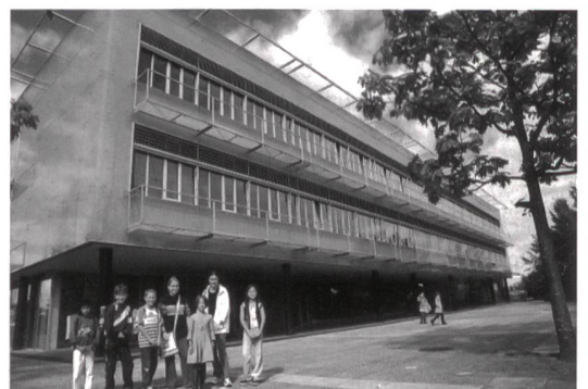
Schulhaus Altikofen: Saniert nach Minergie-Standard.
