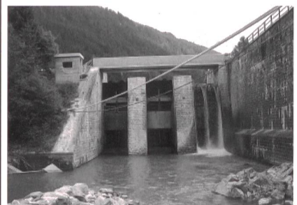
Umgebautes Wehr Burvagn: Ansicht von der Unterwasserseite.
