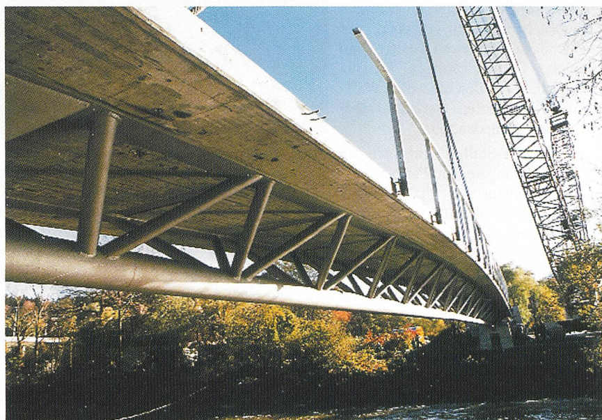
Bild 1 Die Schrägseilbrücke über die Kleine Emme
