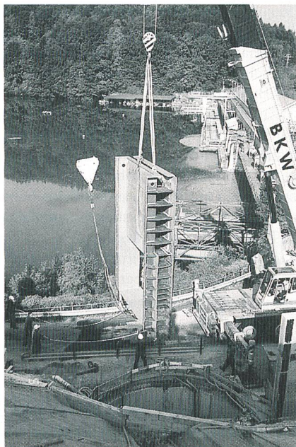
Bild 3 Der 100-t-BKW-Kran hebt das Schützengehäuse an. Im Vordergrund ist der Schachtrand, dahinter das Wehr und das Maschinenhaus des WKW Mühleberg zu erkennen.
