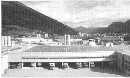
1332 m 2 Modulfläche auf dem Dach der Coop-Verteilzentrale.
