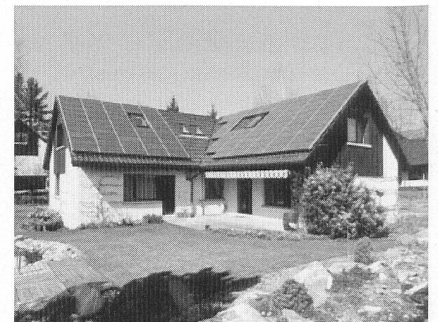
Photovoltaikanlage auf Einfamilienhaus in Nürensdorf.
