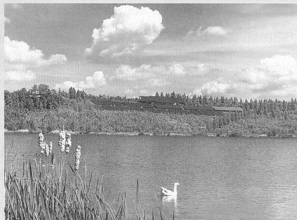
Solarstrom soll gemäss neuem deutschen Erneuerbare-Energien-Gesetz 99 Pf./kWh erhalten (im Bild Photovoltaikanlage Neurather See/Photo RWE).
