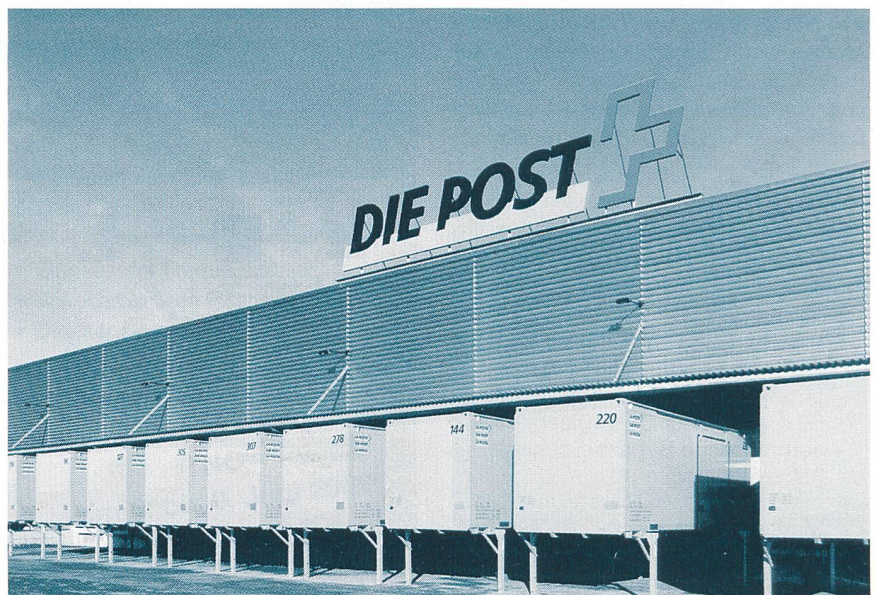
Bild 4 Wechselbehälter der Paketpost 2000 für Bahn- und Strassentransport
