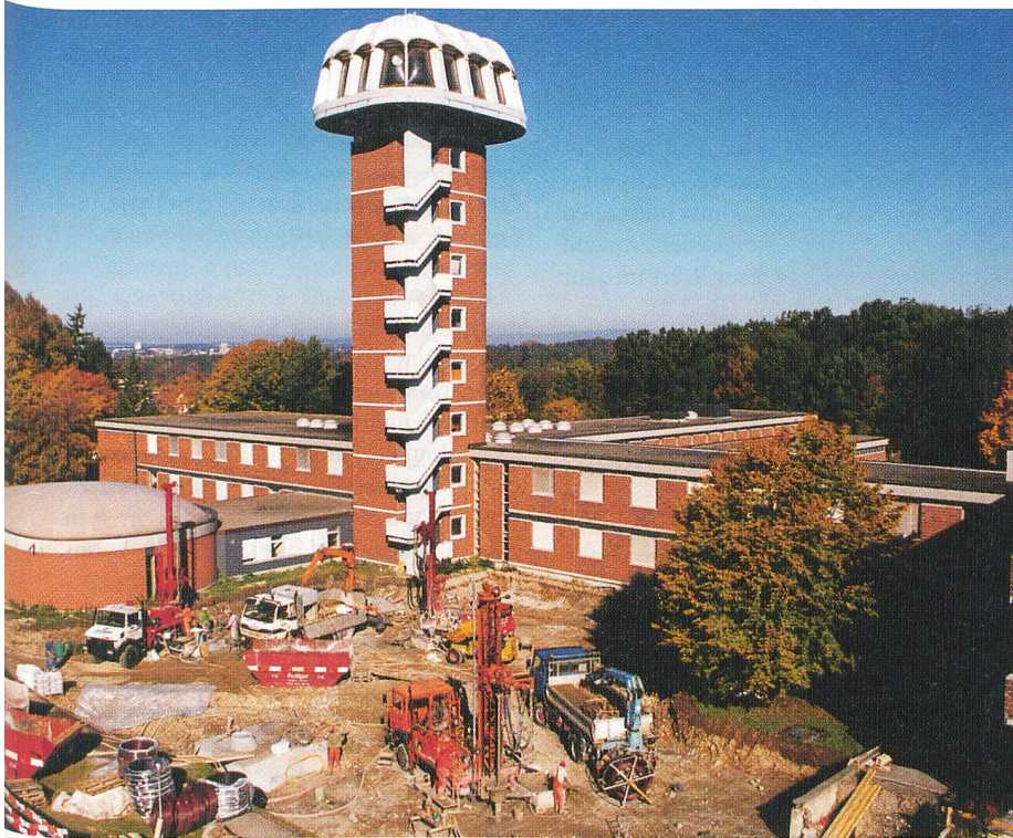
Bild 1 Zwischen den beiden Gebäudekomplexen des Eidgenössischen Amtes für Messwesen in Wabern bei Bern wird nach Erdwärme gebohrt (Fotos: Franz Beyeler, Bern).
