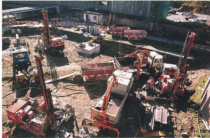
Bild 5 Insgesamt standen drei Bohrergeräte zum Bohren der 45 Erdwärmesondenlöcher im Einsatz.
