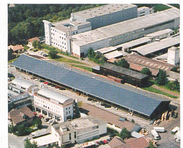
Am Projekt «Solarstrom vom EW» waren Ende 1999 bereits rund 80 Werke beteiligt (Photovoltaikanlage auf dem Eidgenössischen Getreidemagazin in Bern).
