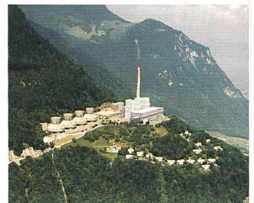
Ölthermisches Kraftwerk Chavillon/Vouvry: Einstellung des Betriebs Ende September 1999.
