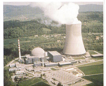
Hohe Arbeitsausnutzung der Schweizer Kernkraftwerke (Kernkraftwerk Gösgen/SO).
