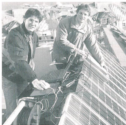
Bild 2 Erfassen von Bildern auf dem Dach der Photovoltaikanlage der HTA Burgdorf
