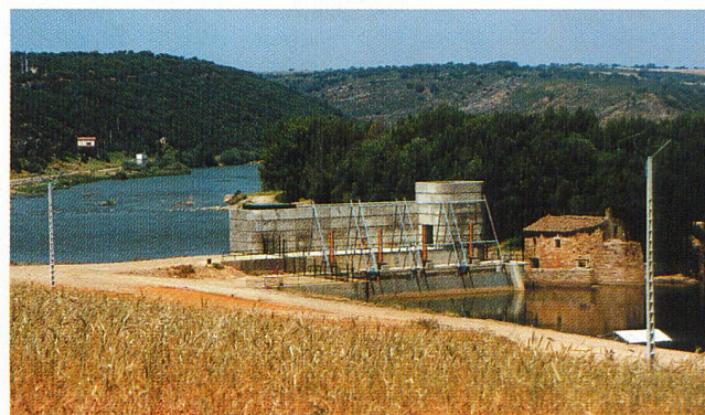
Compensation des INA aussi en Espagne (centrale hydraulique).
