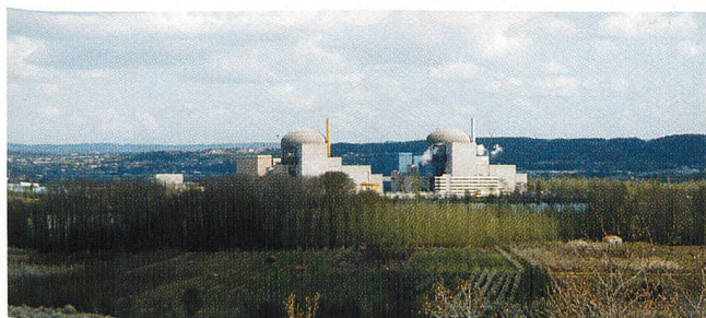
Die Stromerzeugung aus Kernenergie erhöhte sich 1999 in der EU um 1,2% (im Bild Kernkraftwerk St-Alban, Frankreich).
