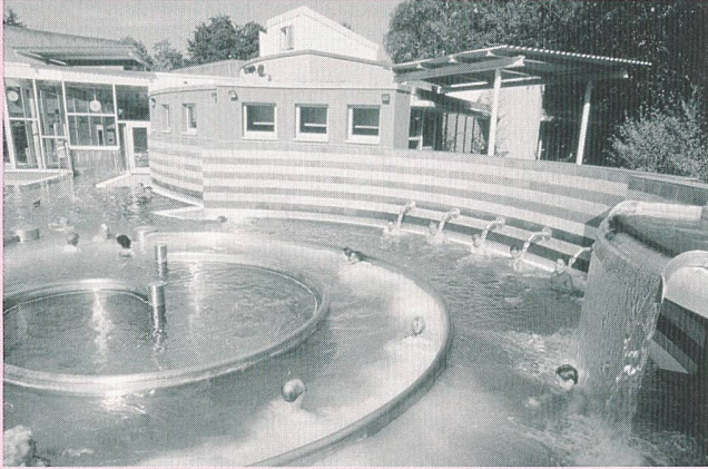
Badelandschaft im Kurzentrum Rheinfelden: Da steckt viel Technik dahinter.
