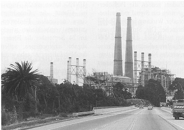
Zu wenig Kraftwerke, zu wenig Reserven; es drohen Stromsperrungen (Ölkraftwerk südlich von San Francisco/Photo K. Niederau).
