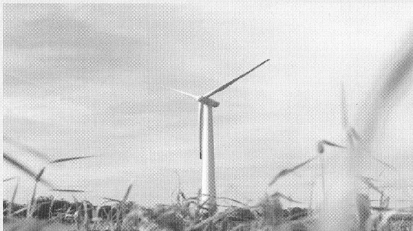
20 Mio. Schilling Schaden bei Brand im Windkraftwerk Zurndorf.
