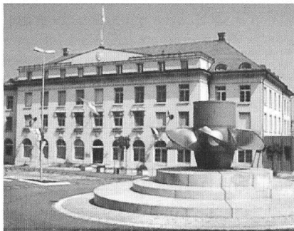
Das Verwaltungsgebäude der IBA in Aarau.
