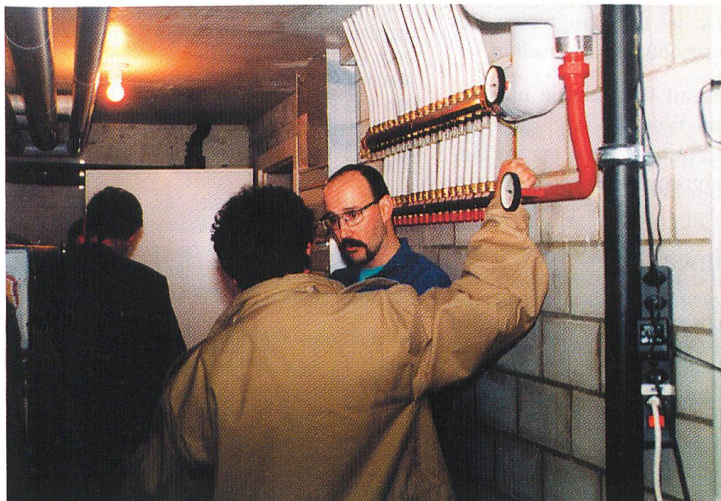
Bild 3 Heizkreisverteiler.
