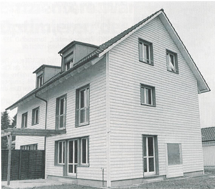
Bild 2 Minergie-Doppeleinfamilienhaus in Grafstal.
