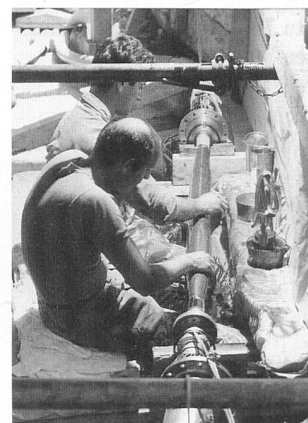
Trassenschächte der Elektrizitätsversorgungsunternehmen: viel freier Platz für Telekomanbieter.
