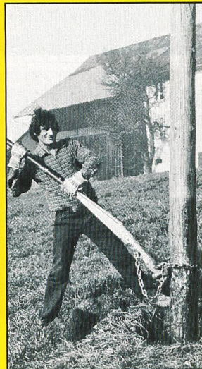
Nachimprägnierung von Holzmasten
