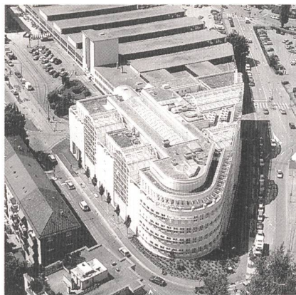
ewz-Betriebsgebäude Oerlikon. Foto: atelier ww
