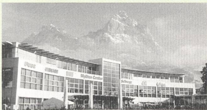
Einkaufszentrum Mythen-Center Schwyz: Gesamtplanung der elektrischen Anlagen durch Elektro-Planung R. Mettler AG
