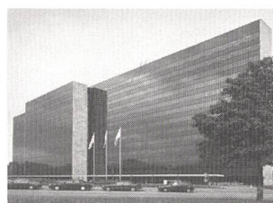
Hauptgebäude der HEW in Hamburg.
