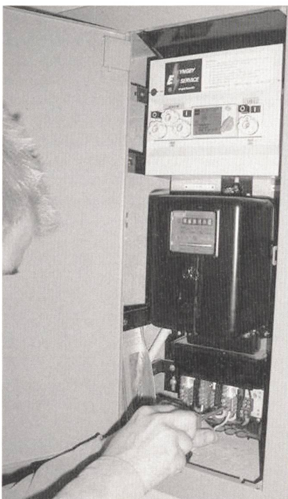
Bild 3 Indoor-Adapter Montage vor dem Zähler
