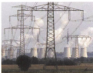
KWK: Verfahrens- und Wirkungsgradverbesserungen sowie neue Technologien notwendig (im Bild Kohlekraftwerk in Ostdeutschland).
