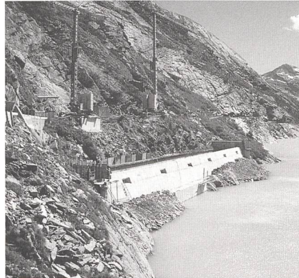
Durch eine Erhöhung der Hochwasser-Entlastung um 2 m können in kritischen Zeiten 3,6 Millionen m 3 Niederschläge aufgefangen werden. (Bild: EGL)
