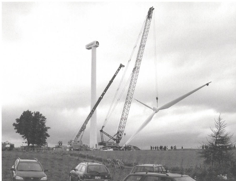
Die Jahresproduktion dieser 76 Meter hohen dänischen Turbine liegt bei 900 000 kWh (Bild: BKW).
