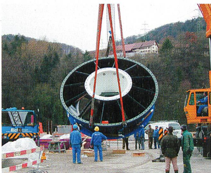
Montage des Turbinen-Leitapparats.
