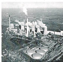
Kraftwerk Scholven, Deutschland.
