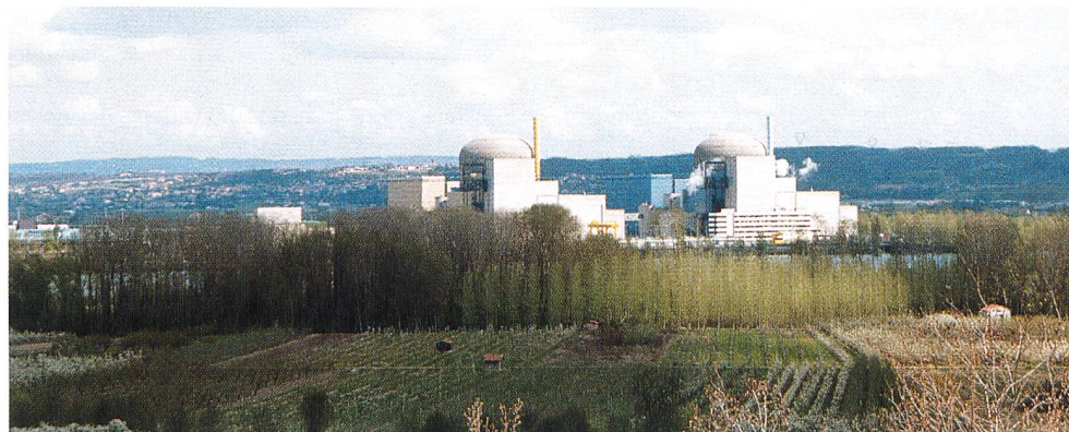
Französisches Kernkraftwerk St. Alban (2X1335 MW/Photo P. Bachmann).
