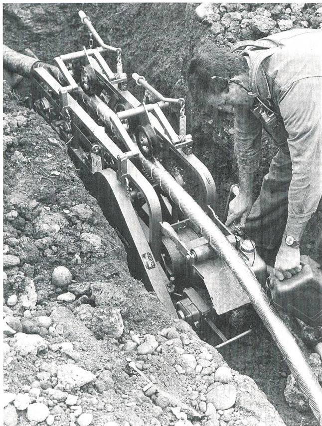
Kostengünstige Stromversorgung oder Landschaftsschutz (Verkabelung einer Leitung mit Kabelzugmaschine)?
