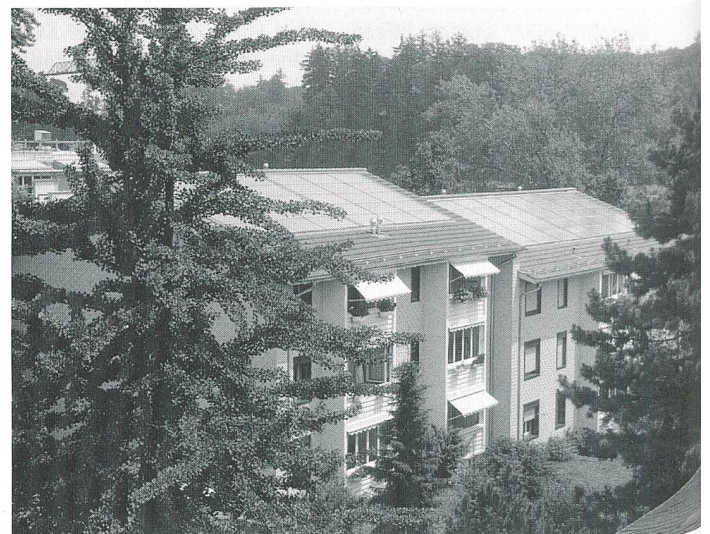
Sonnenkollektoren zur Unterstützung der Warmwasseraufbereitung (Bild Humm).
