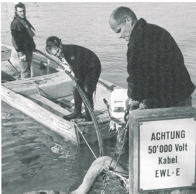
Taucher befestigten neue Telekommunikationskabel am früheren Anschluss des 50-kV-Kabels.
