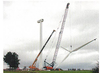
Montage d'une nouvelle éolienne au Mont-Crosin (Jura bernois).
