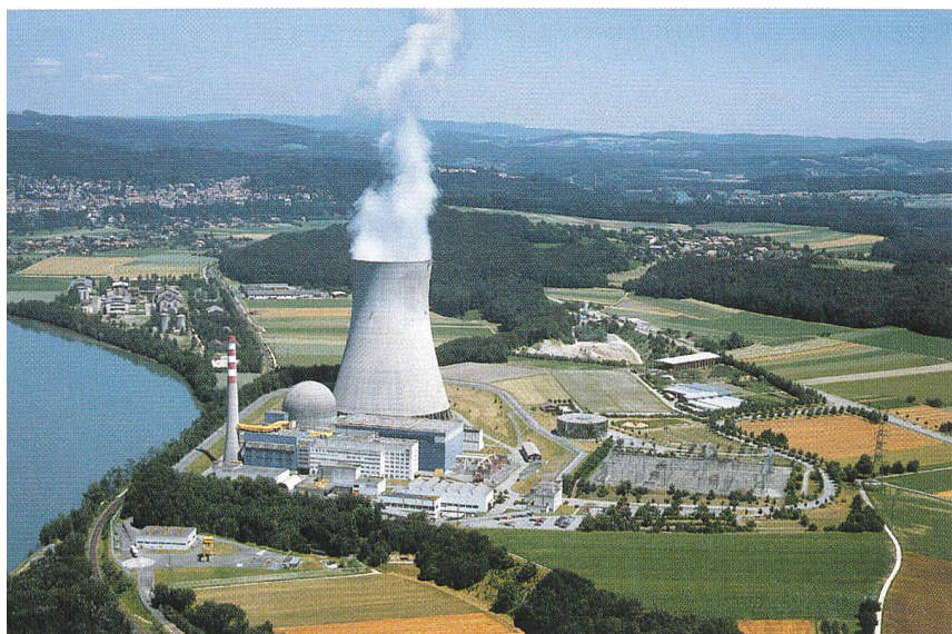
Les initiatives «Sortir du nucléaire» et «Moratoire-plus» seront vraisemblablement soumises au vote du peuple au printemps 2003 (photo: centrale nucléaire de Leibstadt).
