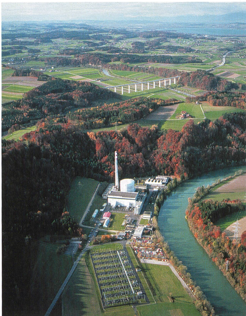
Production record des centrales nucléaires suisses (CN de Mühleberg/BE).
