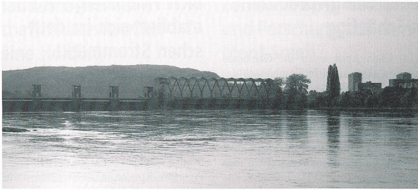
Das Kraftwerk Birsfelden produziert seit 48 Jahren umweltfreundlichen Strom aus Wasserkraft.
