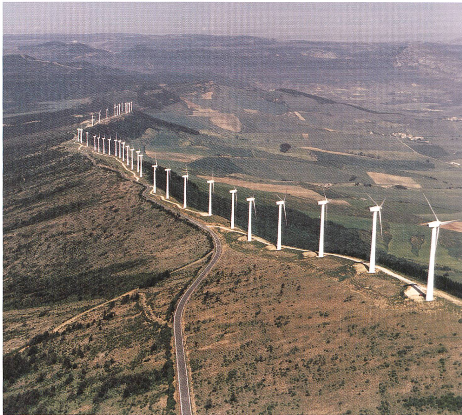
Die EU will erneuerbare Energiequellen prioritär fördern (Windpark in Spanien/Bild EHN).
