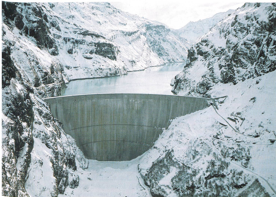
Zusammen mit der Wasserkraft ist rund 60% der schweizerischen Stromproduktion erneuerbaren Ursprungs (Bild EGL: Stauanlage Mauvoisin/VS).
