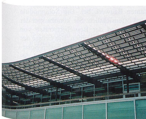
Bild 1 Beschattungselemente auf der Nordseite (Fotos: R. Durot).
