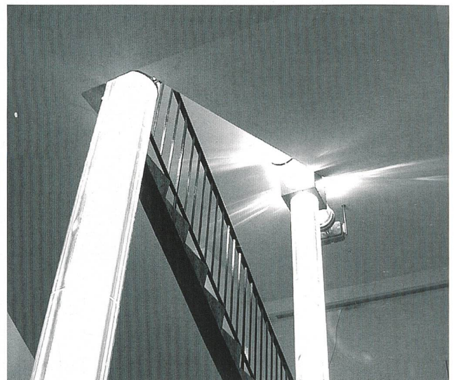
Bild 3 Kunstlicht wird durch Röhren ins Treppenhaus geführt (Bild Semperlux)
