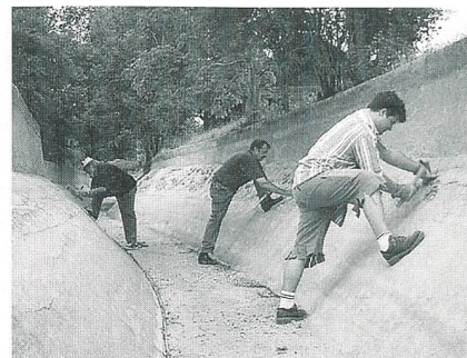
Sanierung der Oberwasser-Kanalmauer im Team.
