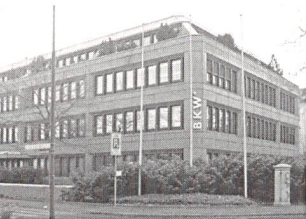
Die Bernische Kraftwerke benutzen für das umfassende Messdatenmanagement Silo-SQL
