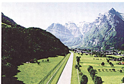
Escherkanal Kundertriet: Der heutige gestreckte Verlauf des Escherkanals mit seinen schmalen Vorländern lässt der Natur nur wenig Raum. (Bild: Linthwerk)
