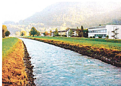
Blocksatz Escherkanal: Der Uferschutz aus Blocksatz oder Betonelementen ist auf weiten Strecken sanierungsbedürftig. Auch aus ökologischer Sicht sind heute andere Lösungen gefragt. (Bild: Niederer + Pozzi Umwelt AG)
