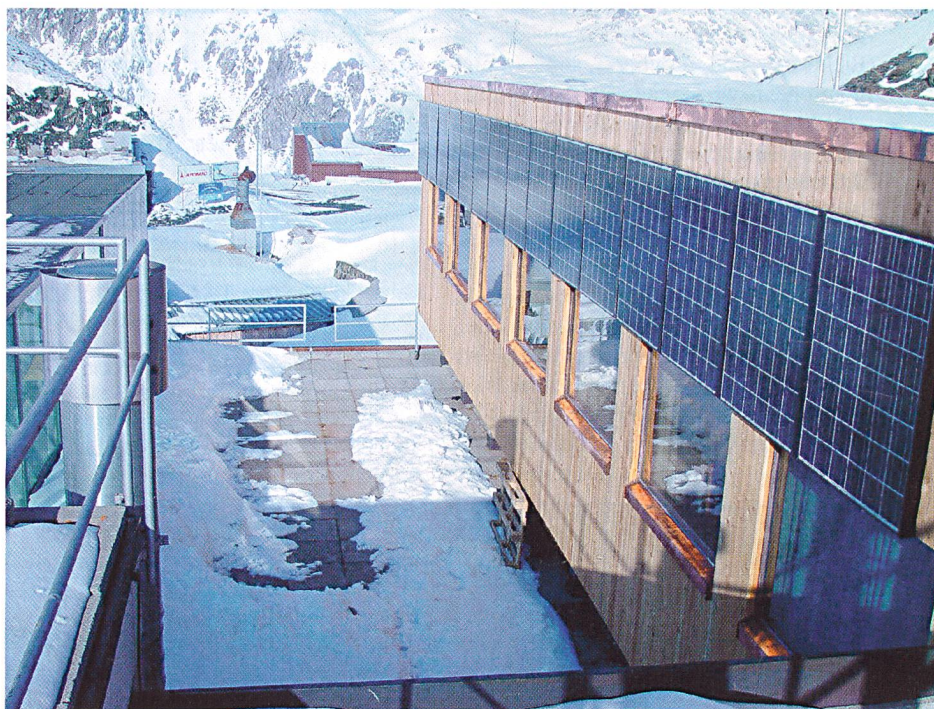
Südfassade des Eidgenössischen Institutes für Schnee- und Lawinenforschung; Dachgeschoss seitwärts.
