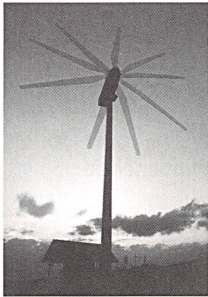
Windkraftanlage Breitnau (Südschwarzwald/Photo Energie-Dienst).
