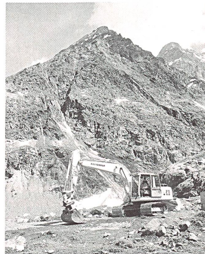
Renaturierungsarbeiten haben bereits begonnen (Bilder: KWO).
